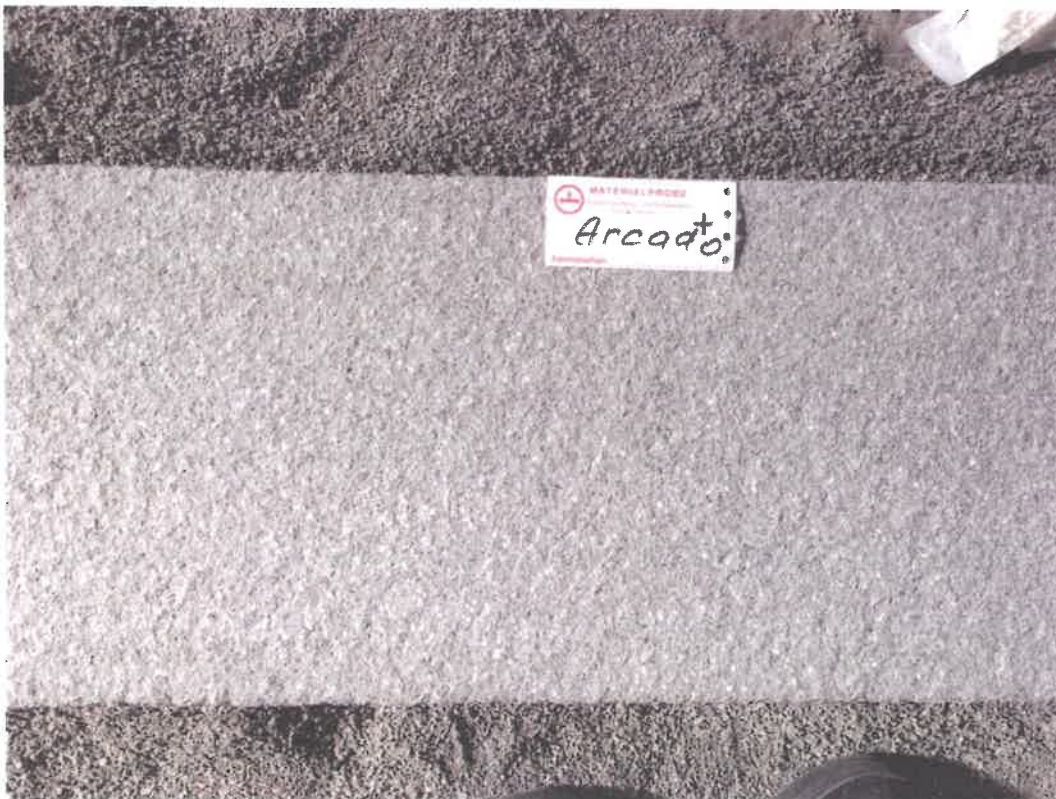
Bild 1. Die zu prüfende Pflasteroberfläche ARCADO im aufgebauten Zustand.
